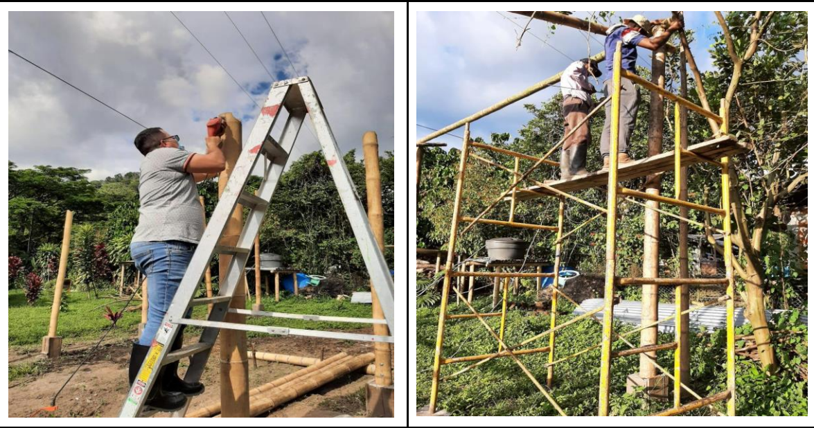
Fotografías 7 y 8. Instalación de vigas y columnas en guadua.
