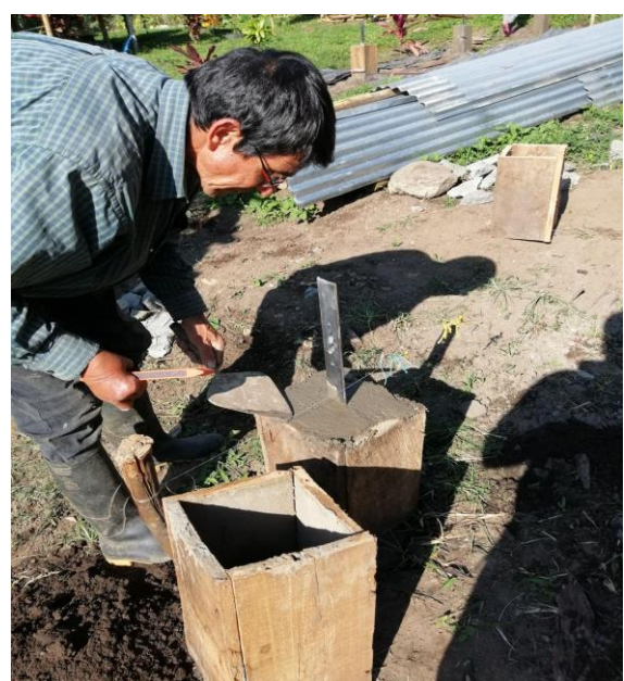
Fotografías 5 y 6. Construcción de pilotes para el invernadero.
