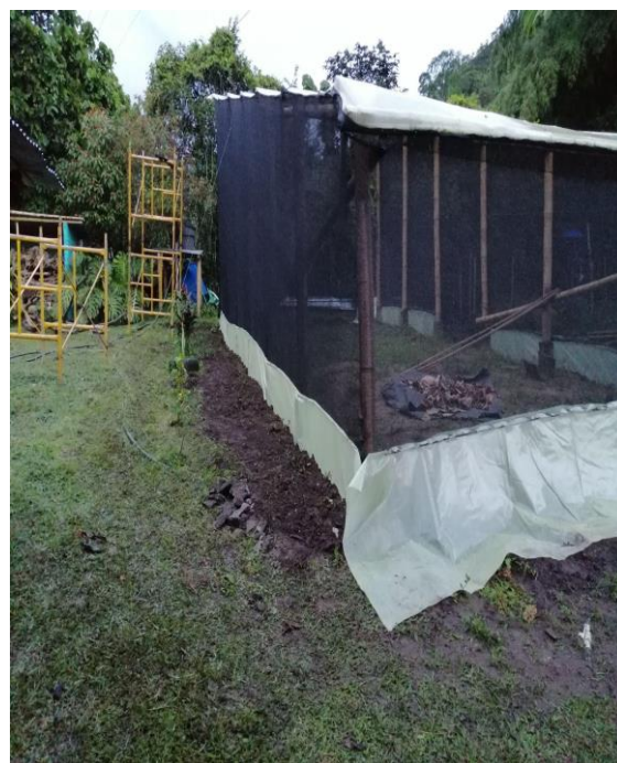
Fotografías 13 y 14. Instalación del cerramiento del invernadero.
