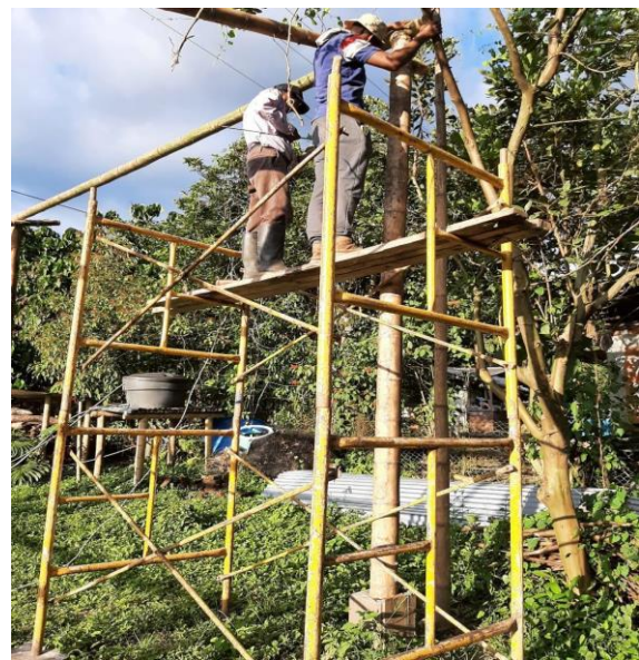
Fotografías 5 y 6. Construcción de pilotes para el invernadero.
