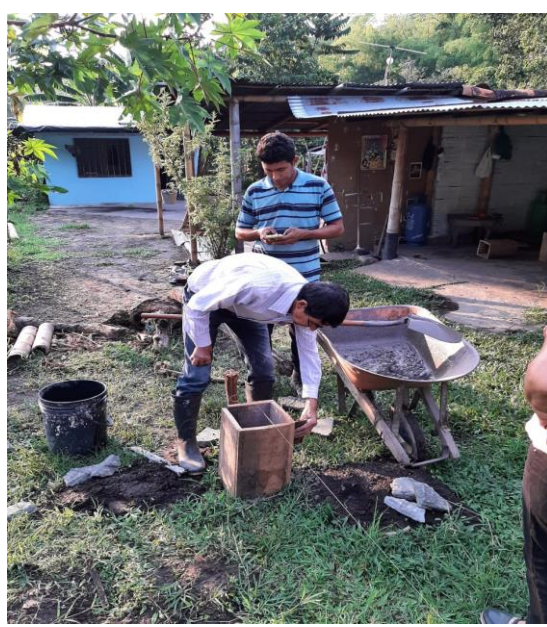
Fotografías 5 y 6. Construcción de pilotes para el invernadero.
